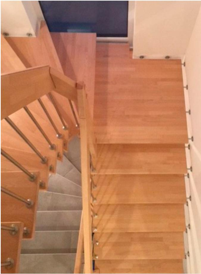
Handlaufgetragene Treppen sind eines der Kernprodukte des Unternehmens. Systemgeber ist RCD Treppensysteme aus Hude
