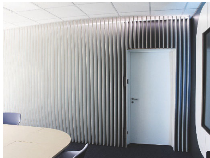
/ Fertigschnitt: Der DP-Schaftfräser Z3 ermöglichte, dass die 62 Lamellen ohne große Nacharbeit eingebaut werden konnten.
